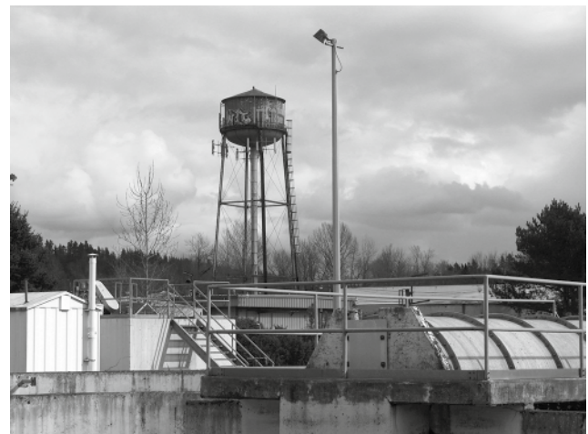
Abbildung 3: Brachliegende Kläranlage, Gebäude und Wasserturm auf dem Modellstandort
