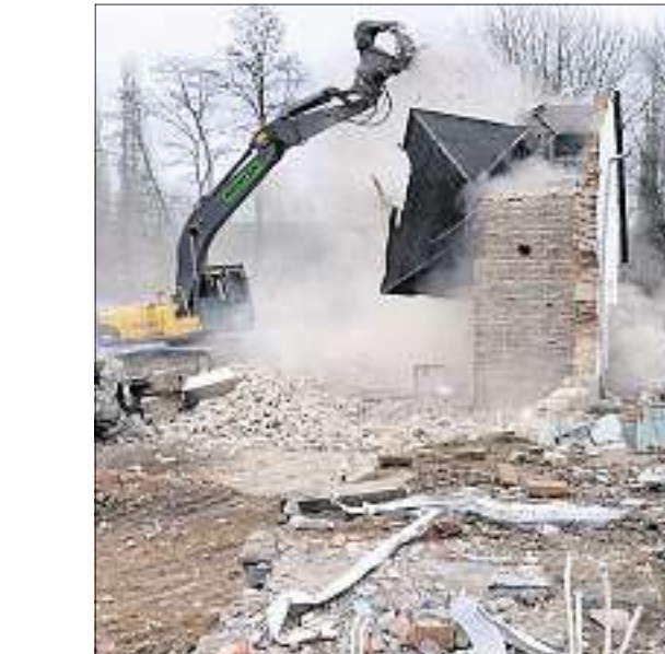
Das letzte Gebäude wird dem Erdboden gleich gemacht. Foto: Klaus Moritz
