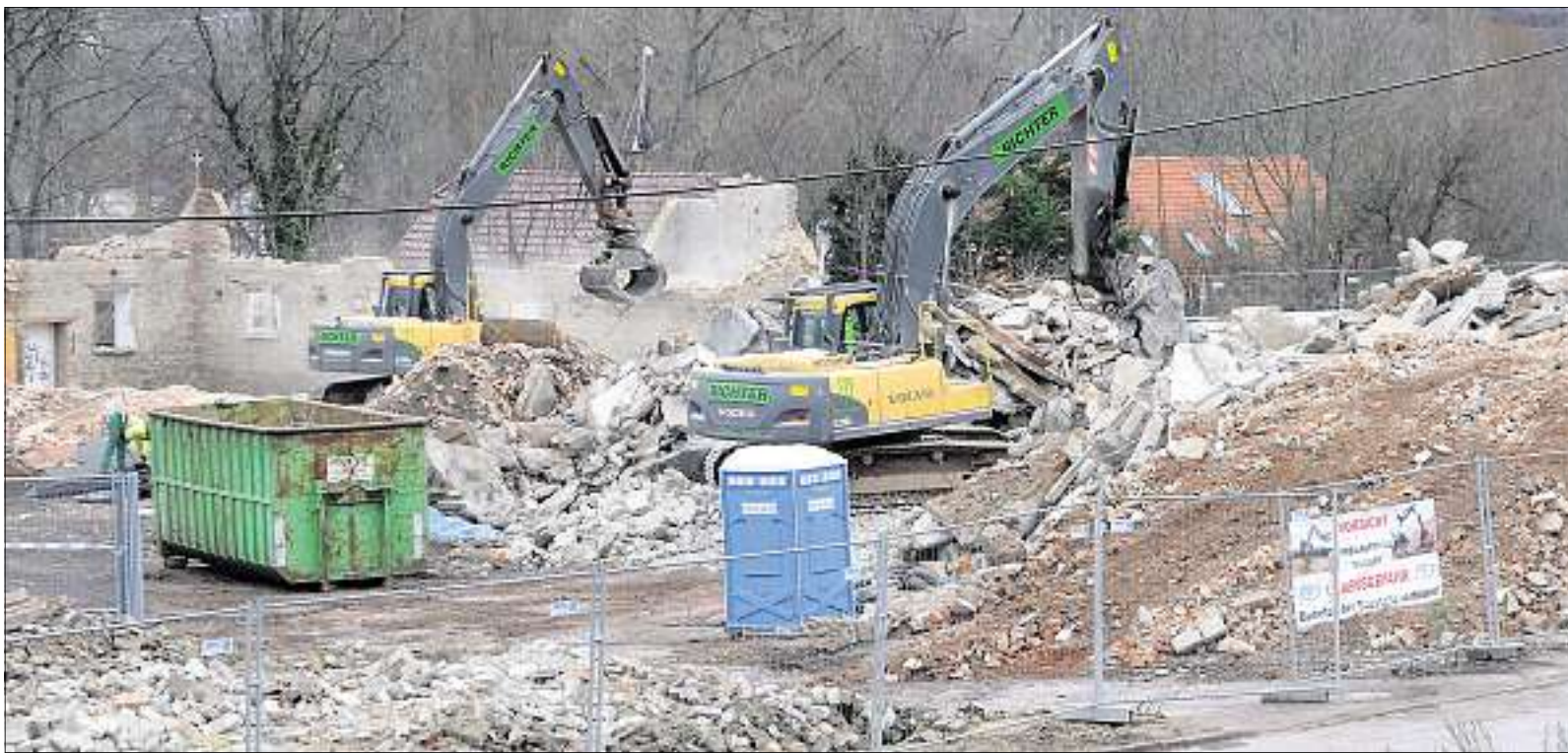
Sämtliche Bauten am ehemaligen Saalfelder Schlachthof sind mittlerweile durch die zwei Volvo-Bagger vom Abbruchunternehmen Richter Triga GmbH aus Zwönitz platt gemacht worden. Foto: Klaus Moritz
