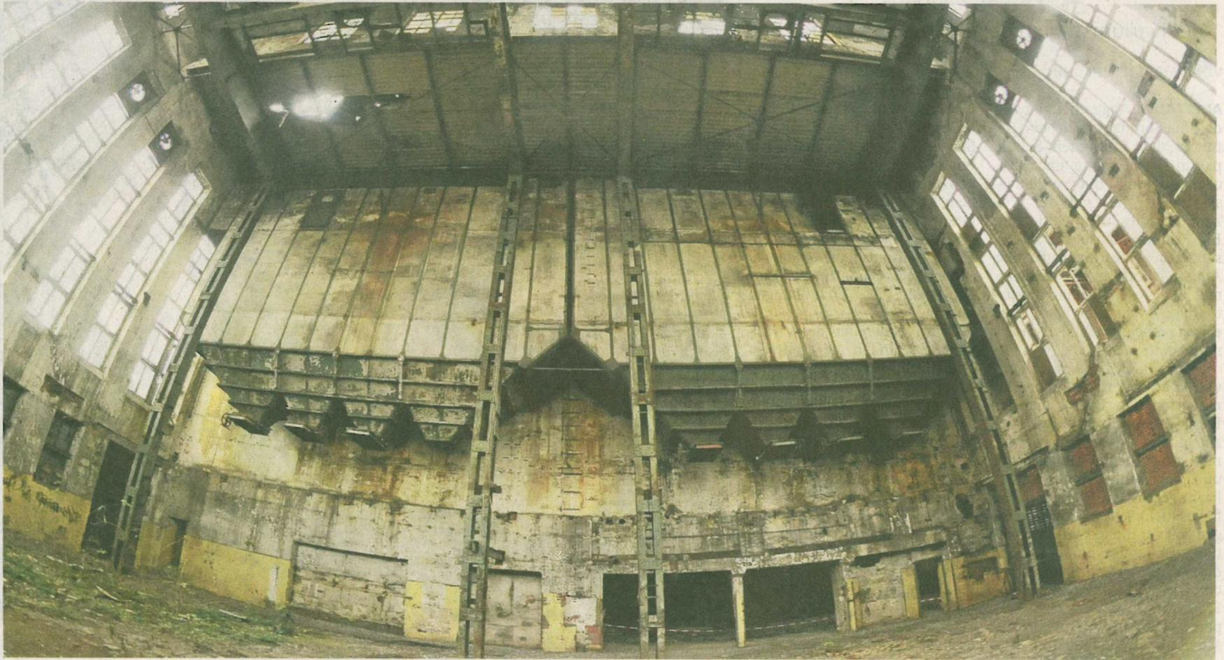
Bereits 2004 wurde das alte Heizkraftwerk von Gispersleben entkernt. Allerdings nicht komplett. Im Inneren warten neben den Beschickungsanlagen für die Öfen noch jede Menge Eisen- und Stahlelemente auf die Demontage.
