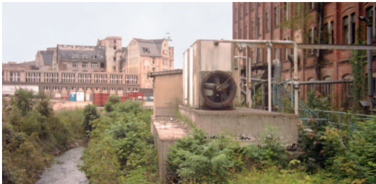
Flusslauf der Kotschau und denkmalgeschütztes Fabrikgebäude
