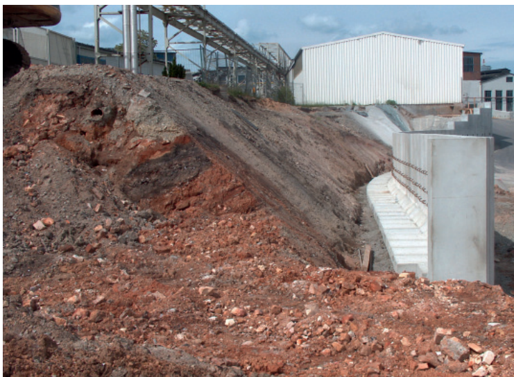
Winkelstützwand zur Schaffung von Wiedereinbaukapazitäten
