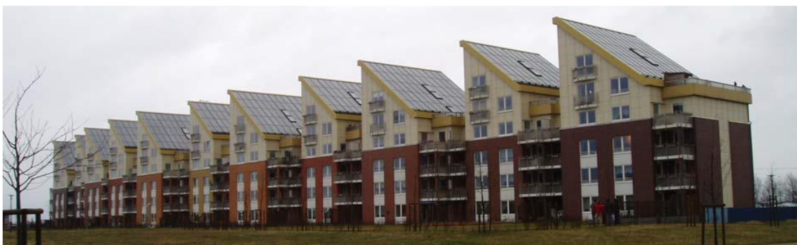
Abbildung 6: Wohnkomplex mit solar unterstützter Nahwärmeversorgung in Rostock-Brinckmannshöhe [Schmidt und Müller-Steinhagen 2004, S. 1]
