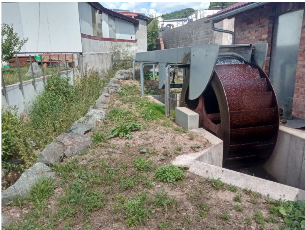
Abbildung 11: Wasserkraftanlage am Grumbach in Bad Liebenstein, OT Steinbach (Thür.), links das Mutterbett des Baches, rechts das ober-schläch-tige Wasserrad mit Gerinne und Maschinenhaus (eigenes Foto vom 21.07.2022)
