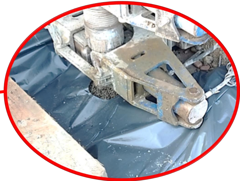
Bohrlochabdichtung mittels Quellton
