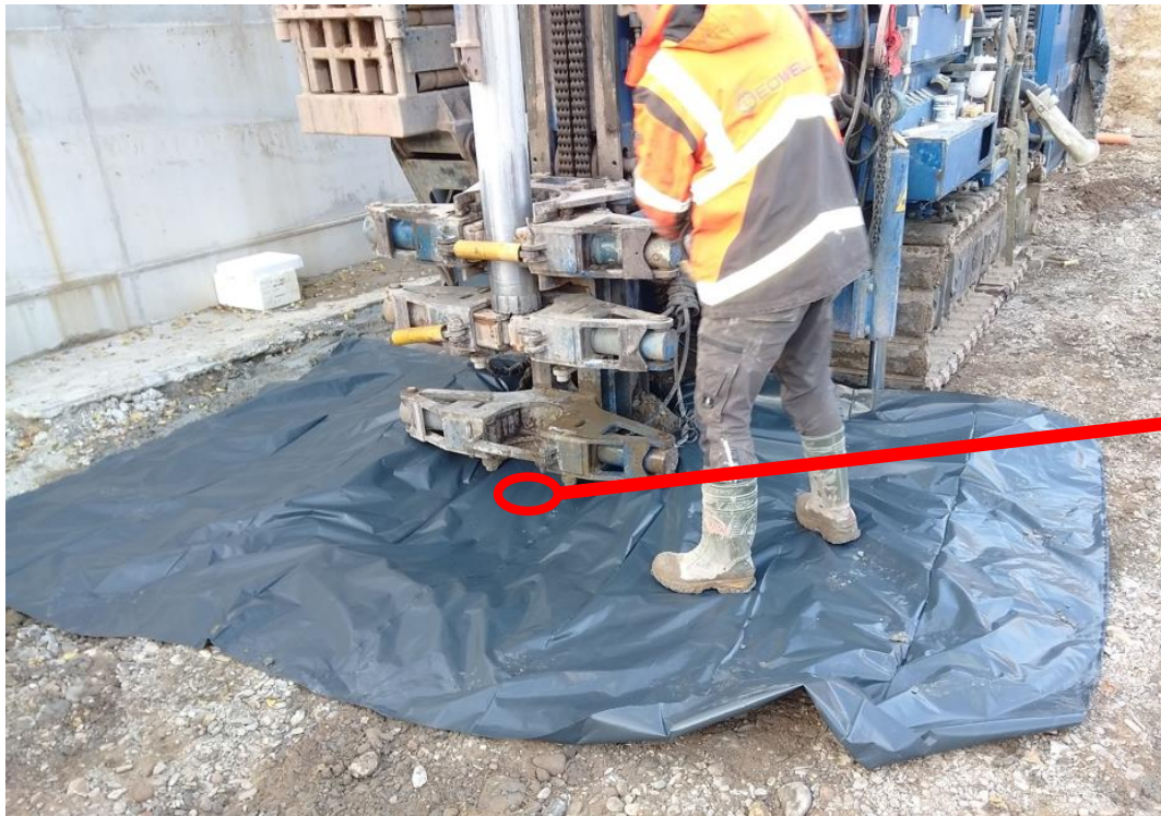
Auslage einer Folie am Bohrplatz
