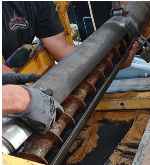
Einbau der Halbschalen
