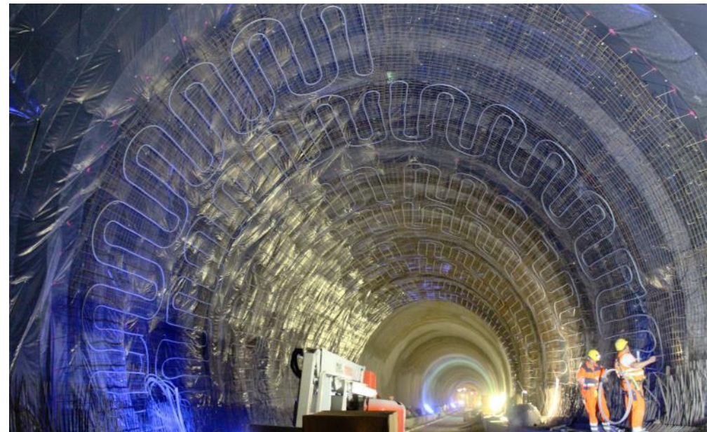
Flächenkollektoren: Beispiel Tunnelthermie
